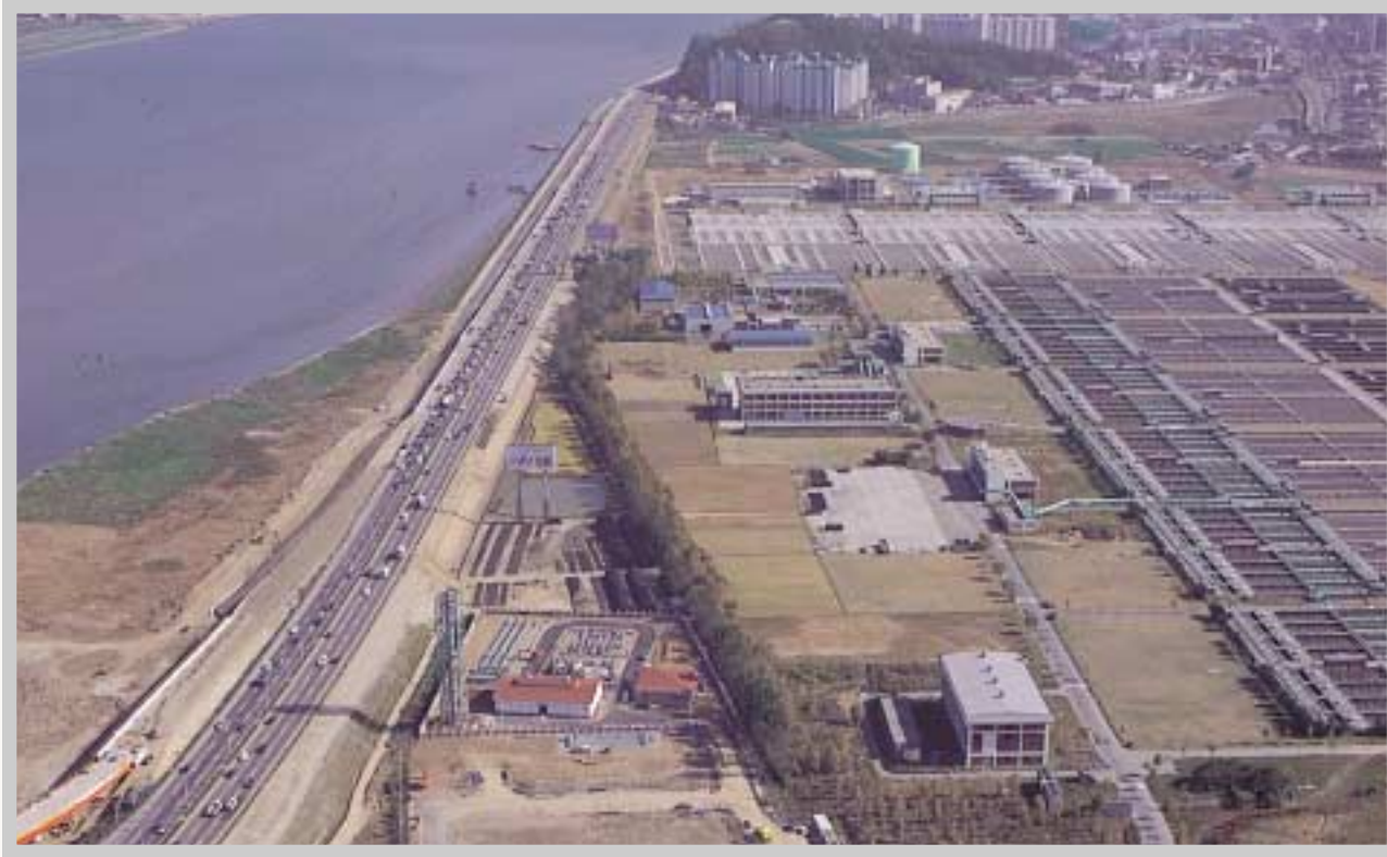
서남 하수처리 사업소 Seanam Sewage Treatment Plant
